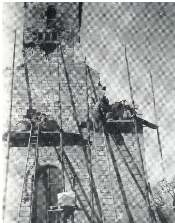
Les villageois entreprennent les travaux de reconstruction
